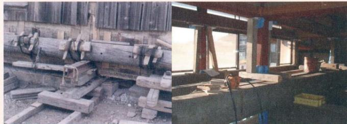
丸太と柱を縛り持ち上げる『丸太工法』を行っていました。壁に穴を開け結束線で絞めて固定します。建物の傷みや補修箇所が多く、曳家工事自体が安く済んでも建築工事全体の費用は高額になっていました。現在ではほとんど見かける事もなくなりました。
