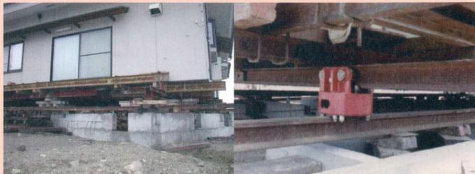
資材が鉄骨・レールに変わり長いスパンを飛ばす事も可能になり、柱を結束せず土台から持ち上げる様になりました。コロもレールに合う形に変わり結束をボルトで行う事で『丸太角材工法』から施工精度が著しく向上しました。
