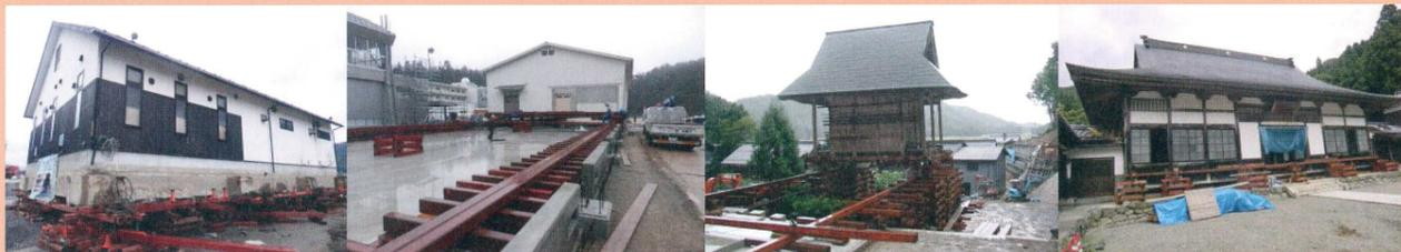
基礎の剛性を失わない様、また建物の傷みを少なくするため油圧機器の精度・性能を上げ改良された工法です。材料を軽量化し施工効率も良くなりました。基礎パッキン厚の空間があれば建物を据付可能になり、無駄な開口を作らずに済むため基礎の剛性を損ないません。また独自の油圧ユニットにより施工能力が向上し、建物を基礎ごと移動させる事も可能になりました。
